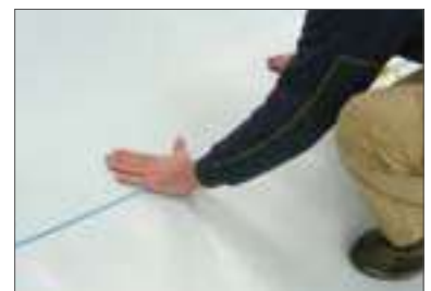
(3) Een goede afdichting van de overlapping verzekeren
