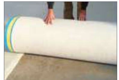
(1) Een overlapping uitvoeren op de aangrenzende band
