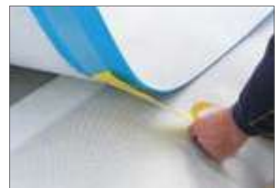
(2) De beschermstrip van de zelfklevende band verwijderen
